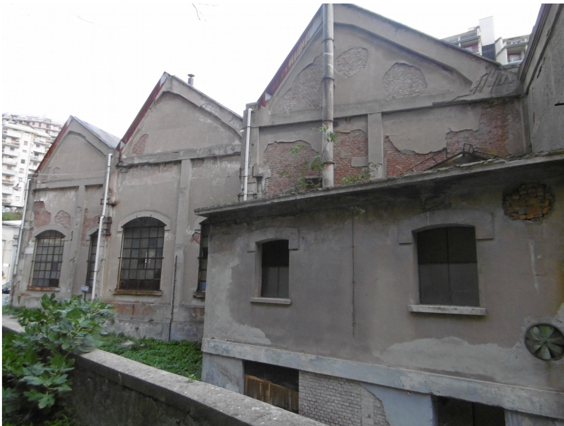
Foto 6: vista capannone B" oggetto di intervento (lato ovest)
