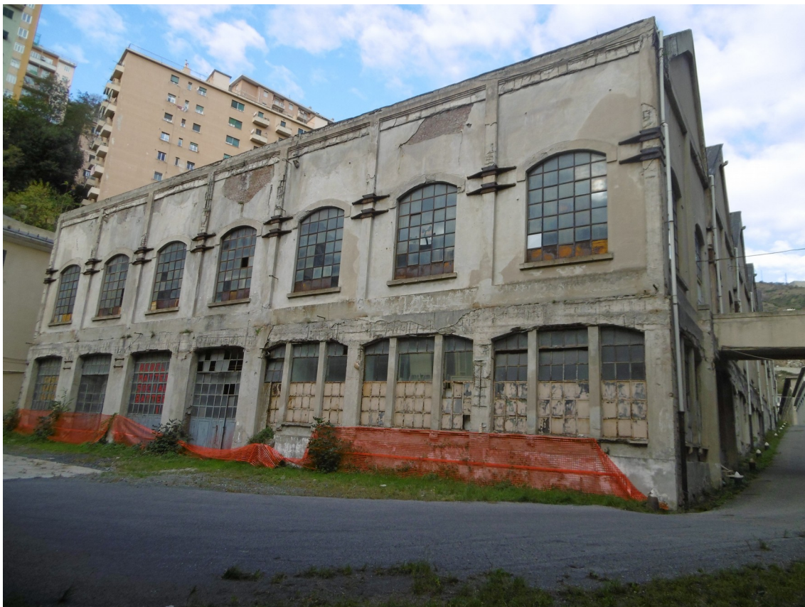
Foto 7: vista capannone B" oggetto di intervento (lato sud)
