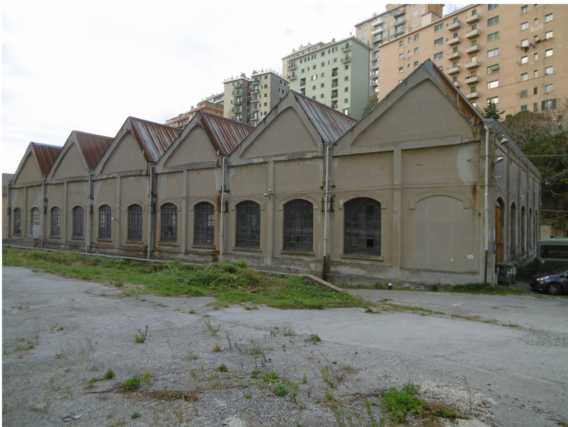
Foto 4: vista capannone B" oggetto di intervento (lato ovest)
