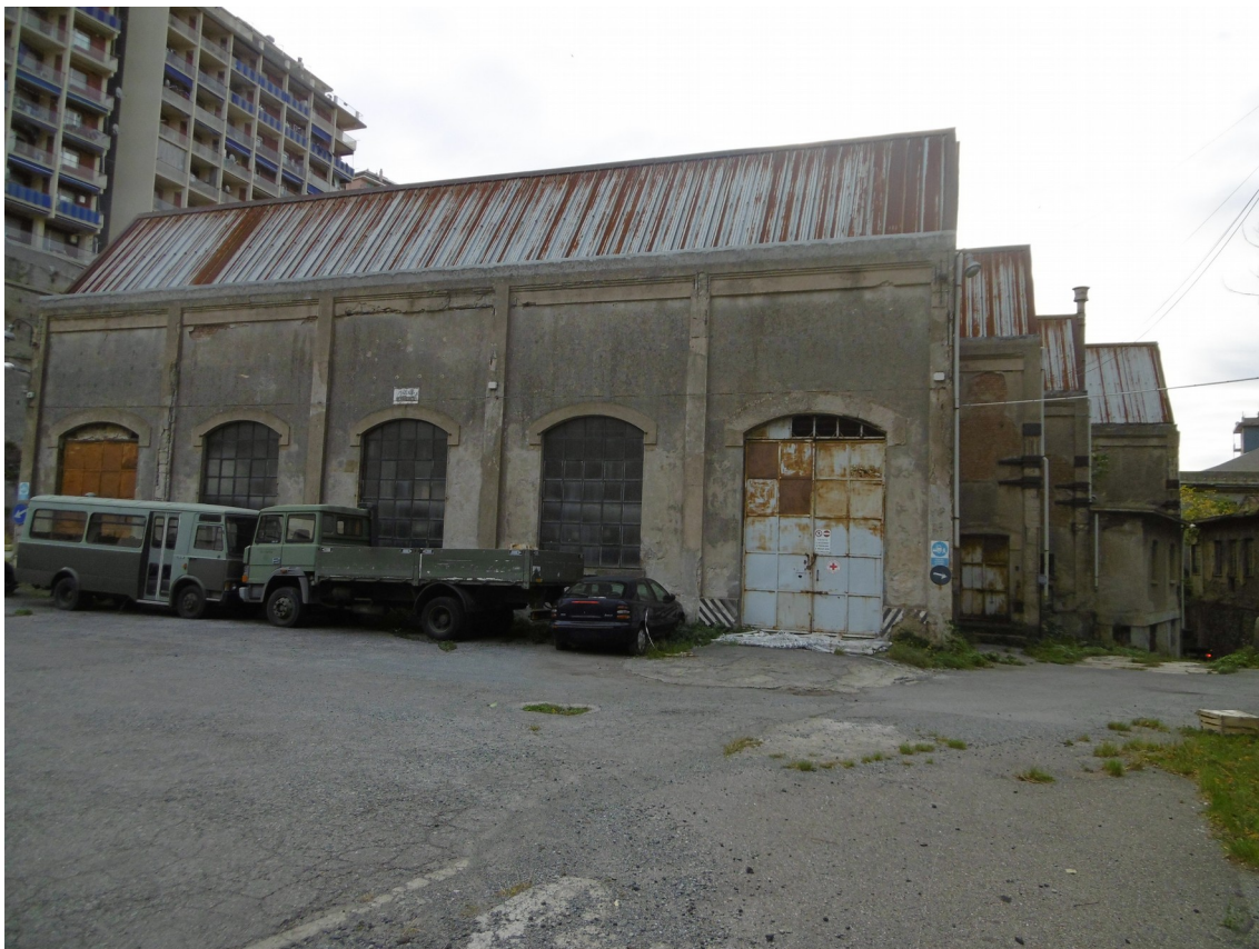
Foto 5: vista capannone B" oggetto di intervento (lato nord)
