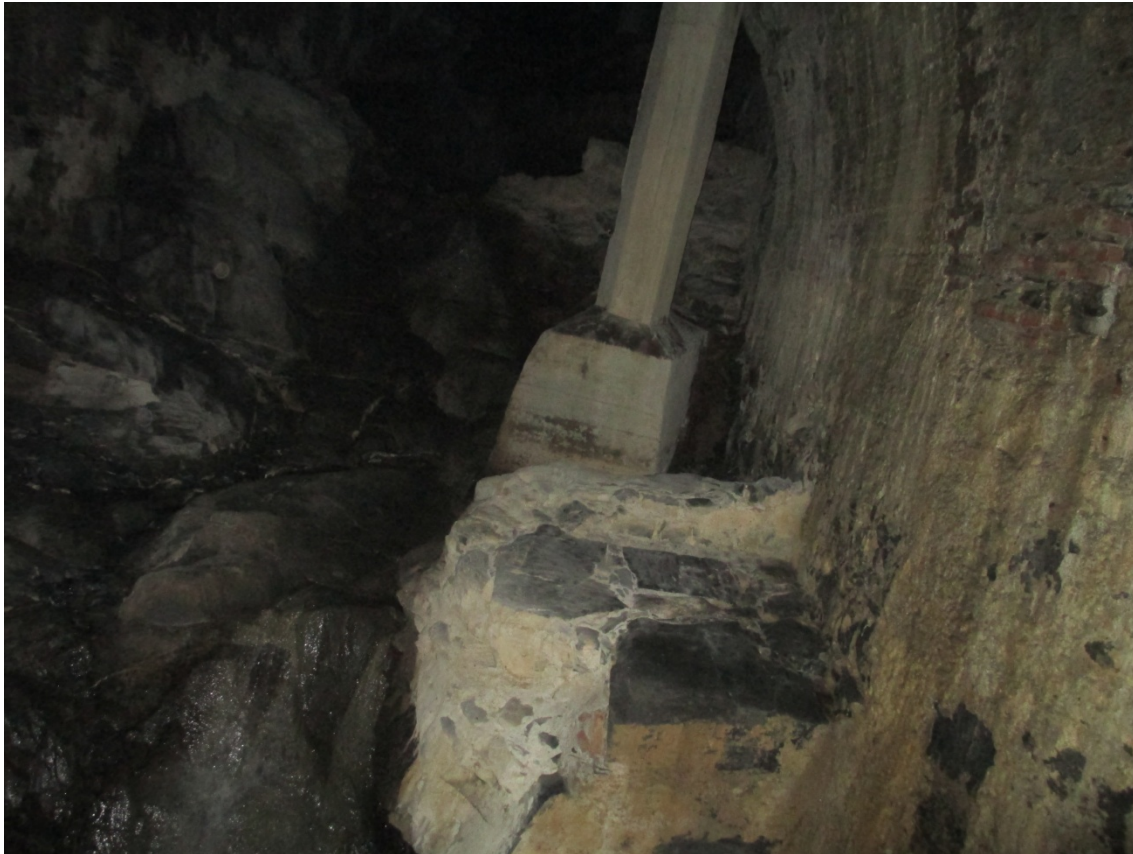
Foto 11: dettaglio tratto tombinato interno
